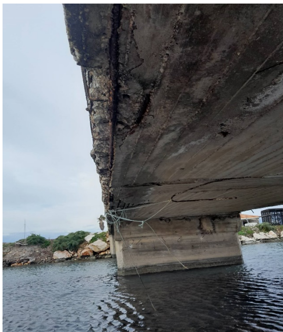
Φωτ. 2. Όψεις των επικίνδυνων φθορών της γέφυρας του κεντρικού στομίου του ιχθυοτροφείου Θολής.
