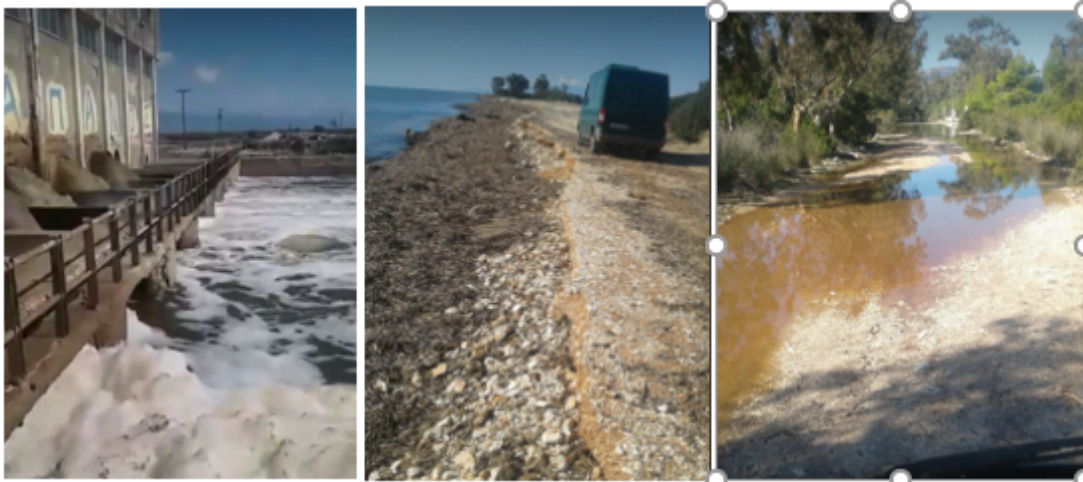
Φωτ. 1. α) Παροχέτευση μεγάλων ποσοτήτων νερού από το αντλιοστάσιο D2, β) & γ) καταστροφές στον δρόμο πρόσβασης του ιχθυοτροφείου από την κακοκαιρία “Μπάλος”- Οκτώβριος 2021.
