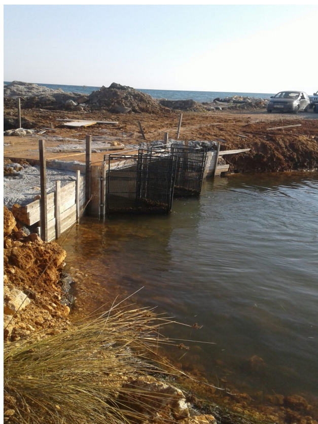
Φωτ. 2. Έργο αποκατάστασης επικοινωνίας με τη θάλασσα στη θέση «Μούντες» – Ιούλιος 2019.
