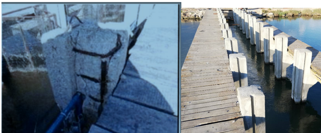
Φωτ. 1. Οι ιχθυοσυλληπτικές εγκαταστάσεις του κεντρικού στομίου πριν (αριστερά) και μετά (δεξιά) τις εργασίες στη λιμνοθάλασσα της Θολής - Ιούλιος 2019.
