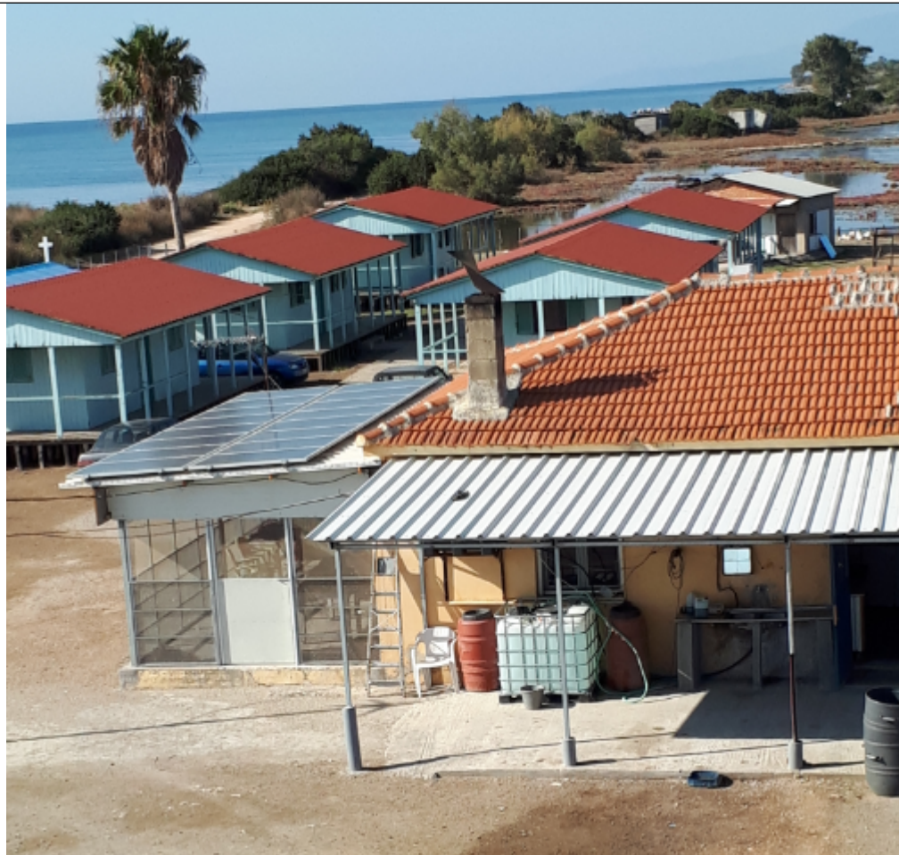
Εικ.4: Τοποθέτηση φωτοβολταϊκών πάνελ και σίτας
